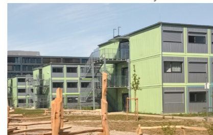
Containerbauweise mit Freianlage, Willy-Brandt-Allee, München Gerstberger Architekten, München Foto: CMS Container Modul Systeme GmbH
